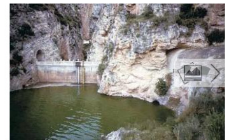
Compuerta del embalse de Camarillas. L. O.
